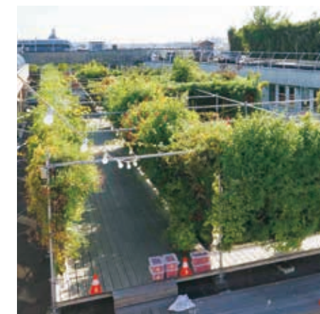
緑の膜を張り巡らせた“農園”。水は膜の下で受け止めて繰り返し使用。屋上から水漏れという心配はない。
