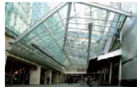
大屋根プラザ
