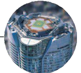
屋上 スカイデッキ
